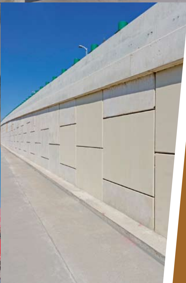
3 Puente Vehicular Paseo Tolloca
