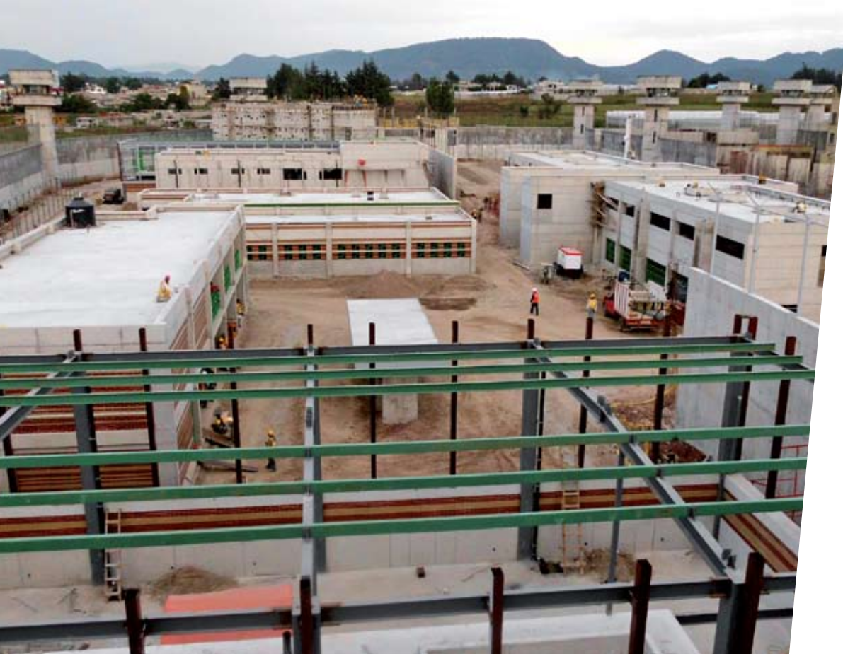
3 Centro Estatal de Rehabili- tación Social de Tenancingo
