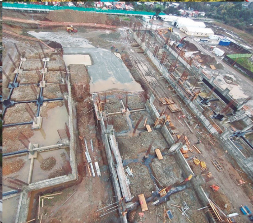
▲ Proyecto: Hospital Los Lagos, Chile
